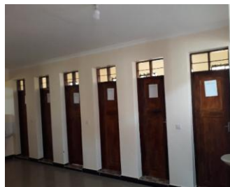
Nye toilet og brusefaciliteter
